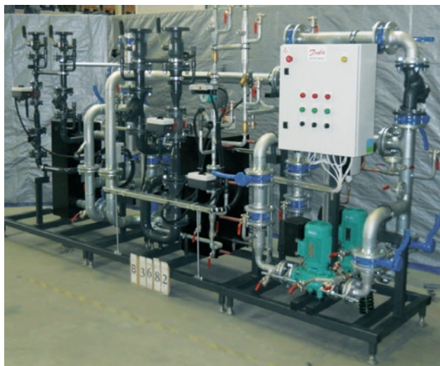
Рис. 36. БТП Danfoss с пластинчатыми теплообменниками.
